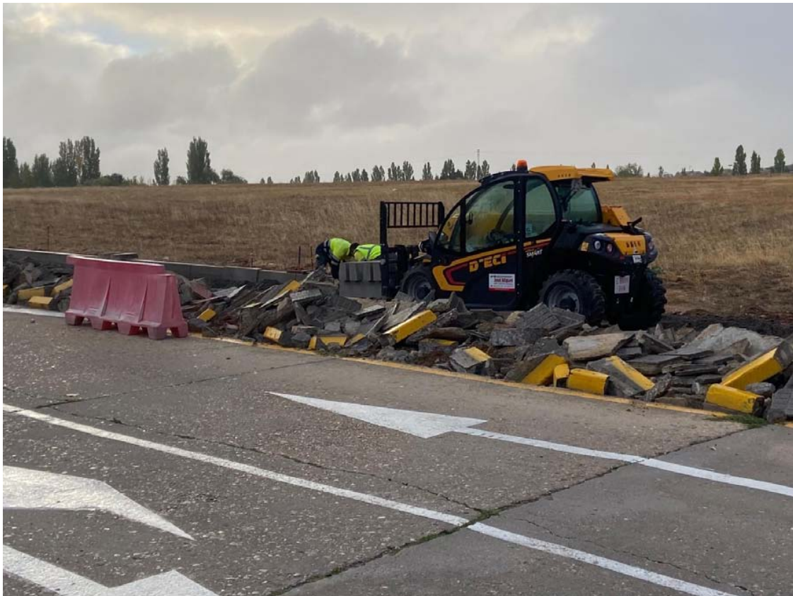
Obras Calle el Greco Santa Marta de Tormes
