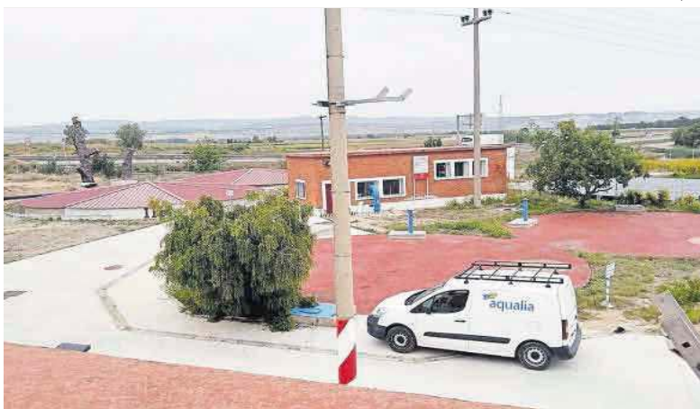
Imagen de las instalaciones de ETAP Alagón, donde Aqualia gestiona servicios específicos.
