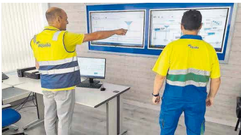
Oficina de telecontrol de las instalaciones.
