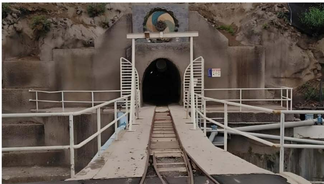
Boca del Túnel de Trasvase por l zona de Hermosilla.
